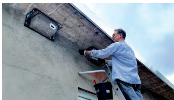
Steffen Fischer montiert am Gymnasium Mauerseglerkästen. Foto: Monica Sandrock
